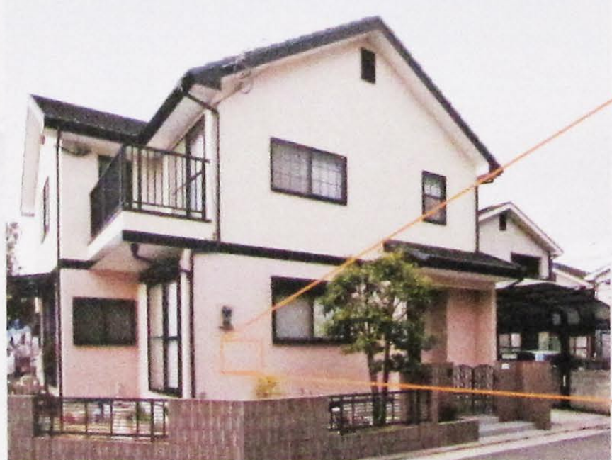
施工実績事例
